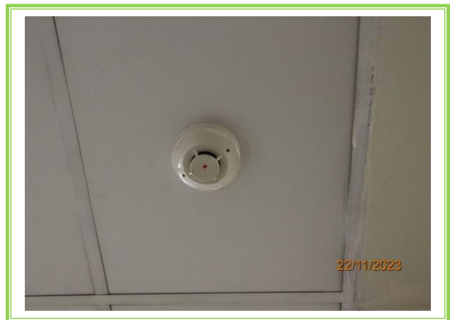
รูปที่ 3-47 เครื่องตรวจจับควัน
